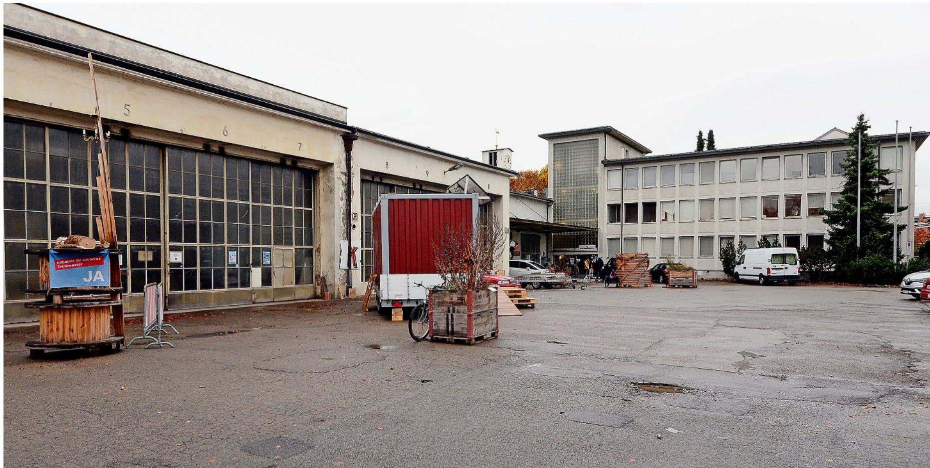
Ein Teil der Hallen und das Verwaltungsgebäude (rechts) bleiben stehen. Sonst wird beim Areal Depot Deutweg alles abgerissen. Foto: Marc Dahinden
